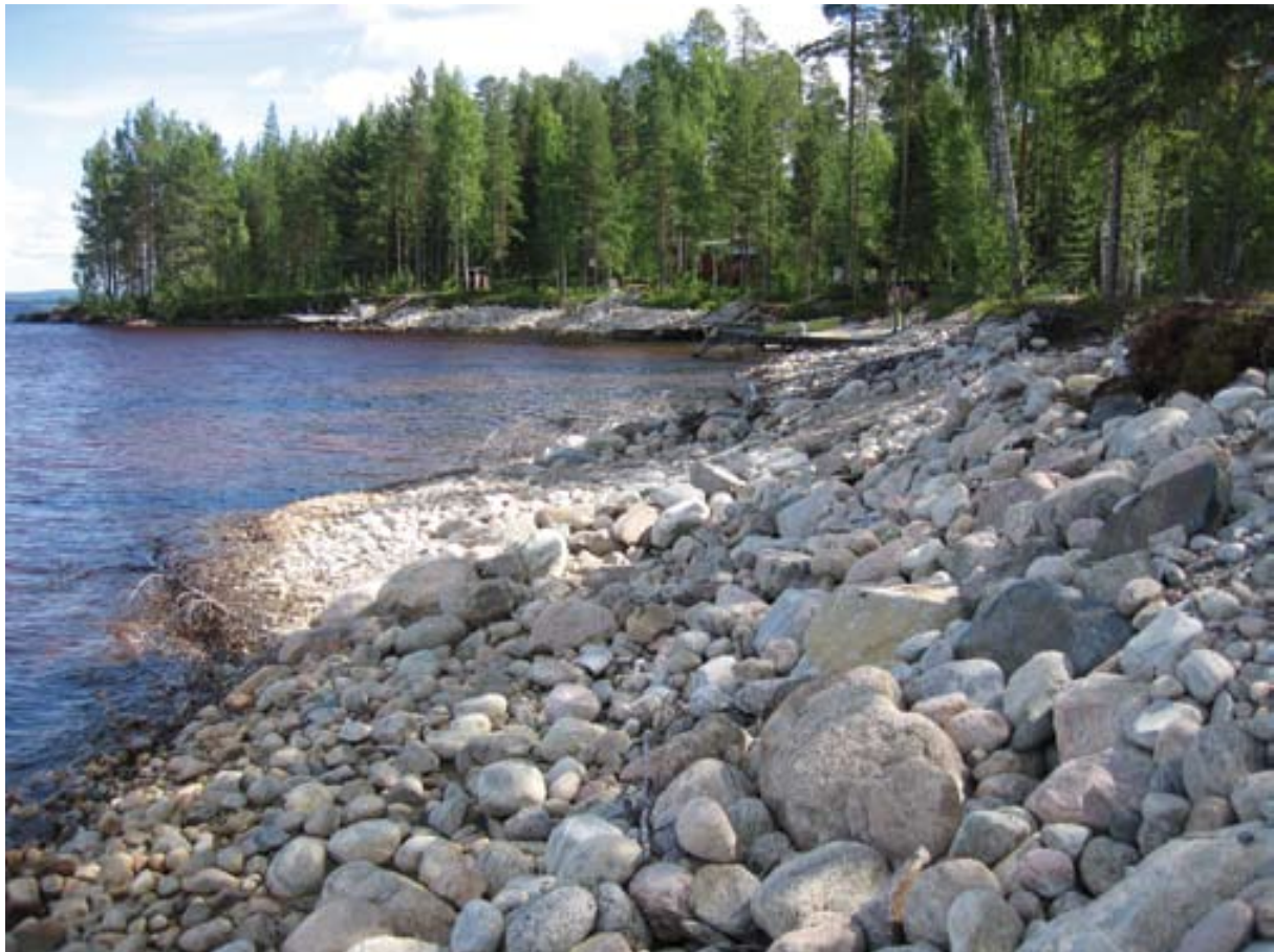
Kuva 14. Rissanranta on esimerkki nopeasti kuluvaasta vyörytörmästä, joka kivettiin loma-asuntojen edustalta keväällä 2004. Järeistä kivistä tehty valli näkyy kauas, mutta vakauttaa rannan varmasti. Kuva: Jukka Nykänen.
