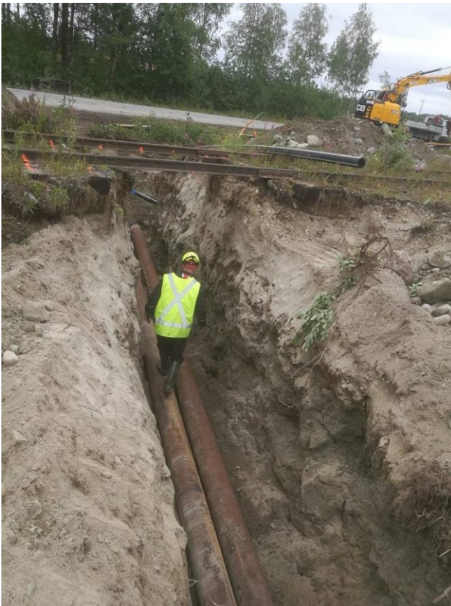
Uutta vesi- ja viemärijohtoverkostoa rakentuu Savotantien varteen.
