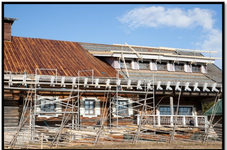
Kuva 4, Kunnan osakkuusyhtiö Kalevanpirtti Oy toteutti ravintola Parpeinpirtin kattoremontin keväällä 2022
